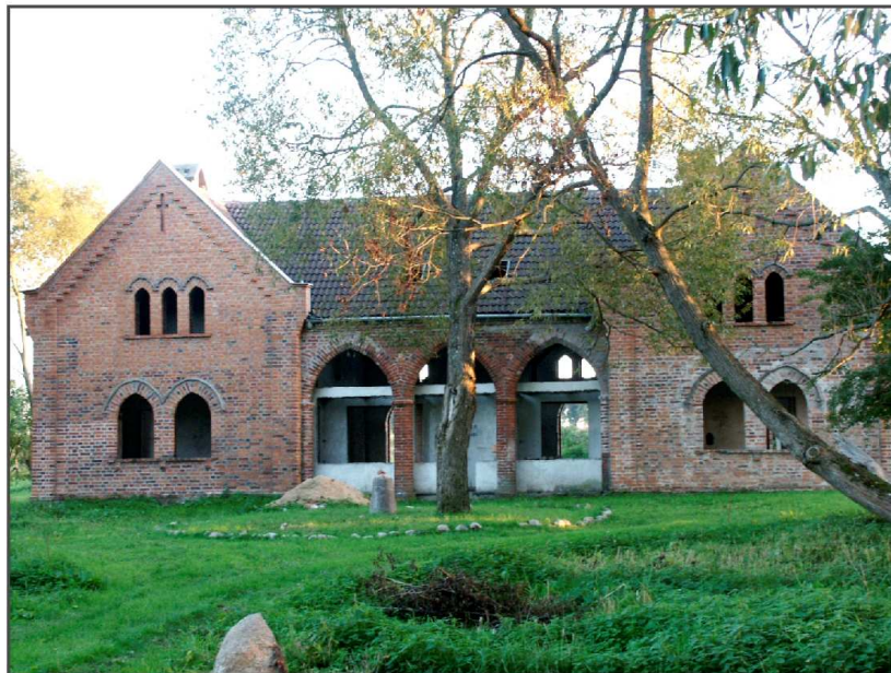
B. Remontowana kuźnia w Pieszczu. Fot. M. Sadowska, 2005
